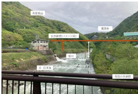
図 3 現地踏査の様子(大網橋周辺)
