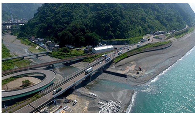
図-1 模型の対処とした橋梁
