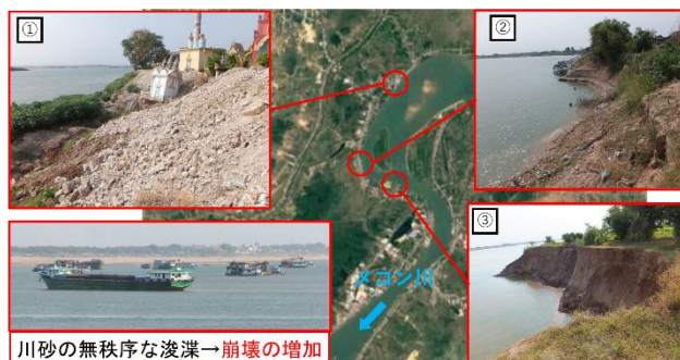
図-1 斜面崩壊現場の被害状況
