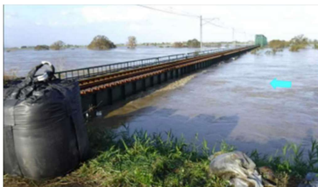
図1 (1) 2019年台風19号によって増水したJR越後線信濃川分水橋梁の様子
