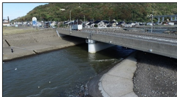
図-2 名立大橋（新潟県上越市）
