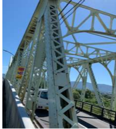
写真-1 長生橋の組立圧縮材 (D2)
