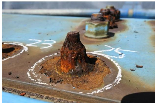
写真-1:実橋におけるボルト腐食状況
