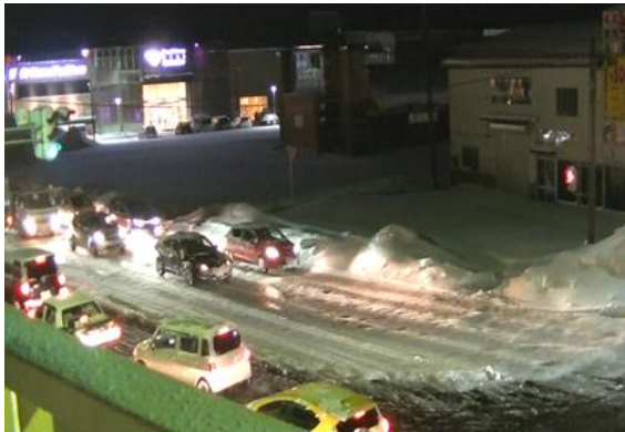
図1 新潟県長岡市要町交差点における冬季の路面状況(圧雪凸凹)
