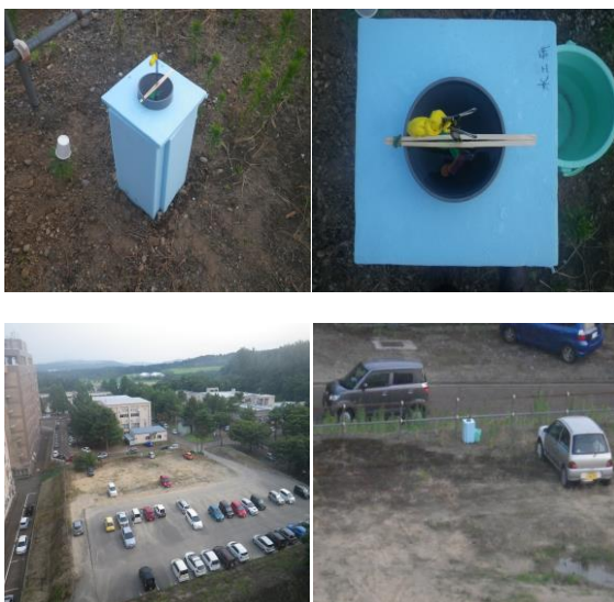
図-3 断熱材で被覆した塩ビ円筒水槽の設置状況
