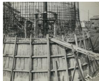
図-3 基礎打設時の状況
