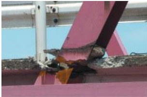
図-1 木曾川大橋
