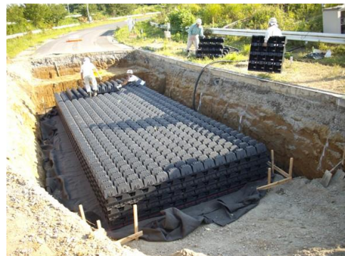
図 - 6 クロスウェーブ施工の様子
