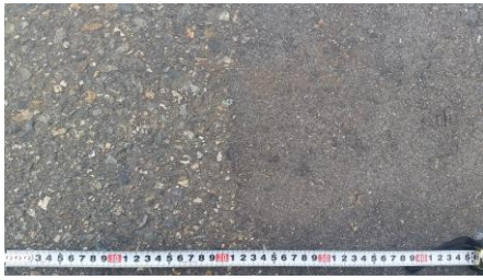
図-3 路面状態(左側：古い舗装, 右側：新しい舗装)
