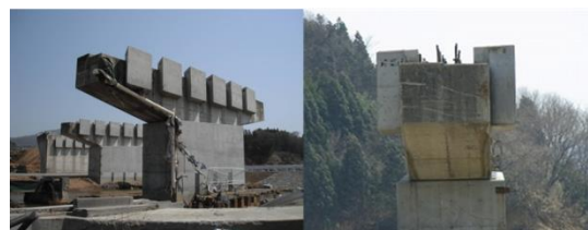
写真-1 落橋防止装置及びアンカーバー
