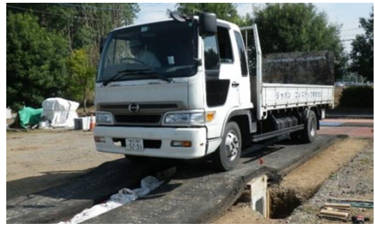
写真 1 走行載荷試験実施状況
