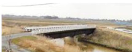
写真-1 対象橋梁
