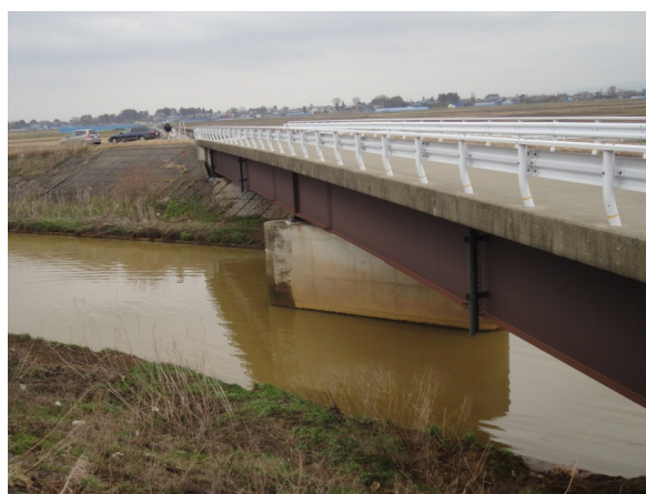
写真2 対象橋梁の全景
