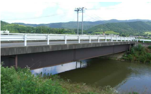
写真1 対象橋梁の全景
