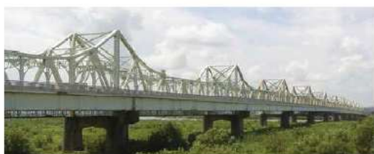
写真-1 長生橋全景
