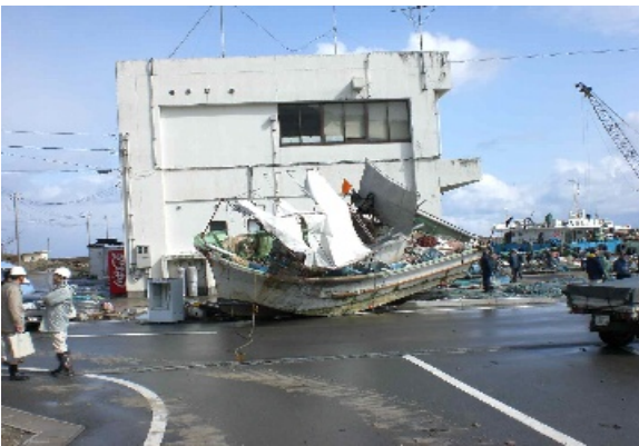
写真-2 陸に打ち上げられた漁船
