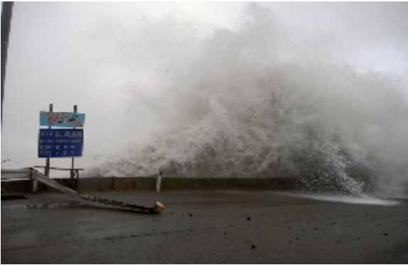
写真-1 北小浦漁港の高波浪の状況
