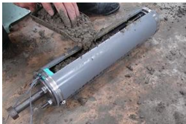
写真-2 打設方法
