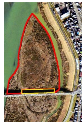
図 9. 長生橋右岸側下流地区
