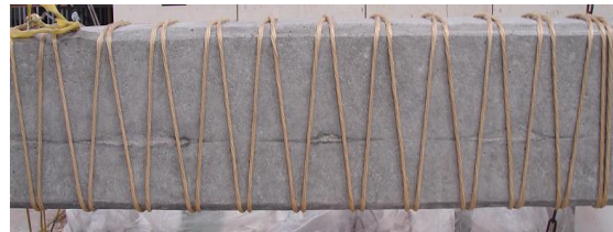
図-3 連続繊維ロープ巻立て状況
