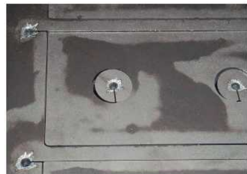
写真-1 切断状況
