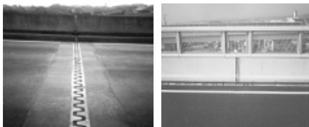
図-1 既存のジョイント(左)と埋設ジョイント(右)
