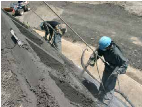
写真2 現場吹付け状況
