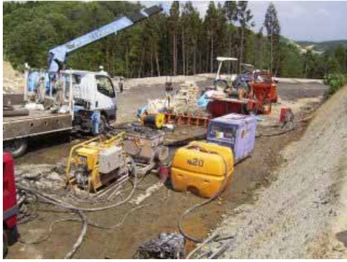
写真1 圧送機およびミキサー
