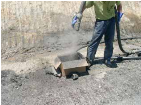
写真3 供試体作成用吹付け状況
