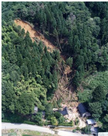
写真-1 出雲崎町中山地区の崩壊現場 （資料：新潟県）
