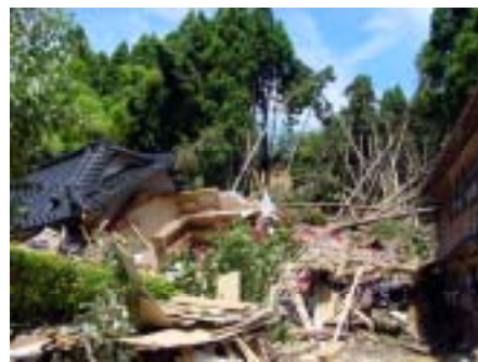
図2 中山の斜面崩壊による家屋崩壊
