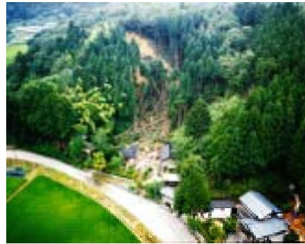
図1 中山の斜面崩壊(北陸地方整備局提供)
