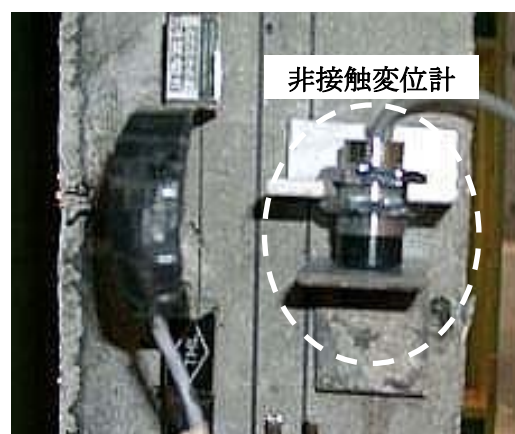
写真-3 非接触変位計設置状況
