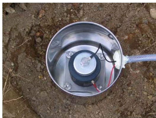
写真-2 加振器設置状況
