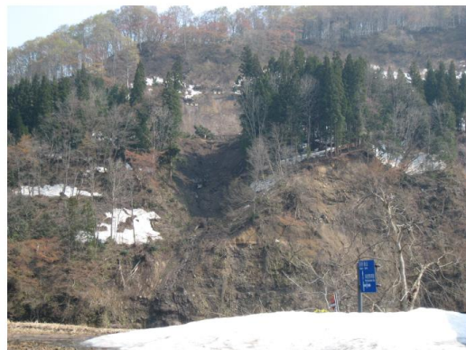
写真 4.3.3_14 斜面の崩壊 (図 4.3.3_6 の No.6 の箇所)
