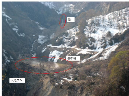
写真 4.3.3_17 北信の斜面崩壊 (湛水湖上部)
