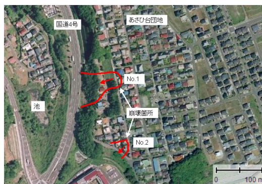
写真 4.3.2_5 崩壊箇所（電子国土のオルソ画像（2007年度撮影）を利用）
