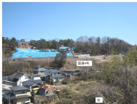
写真 4.3.2_1 あさひ台団地の崩壊全景
