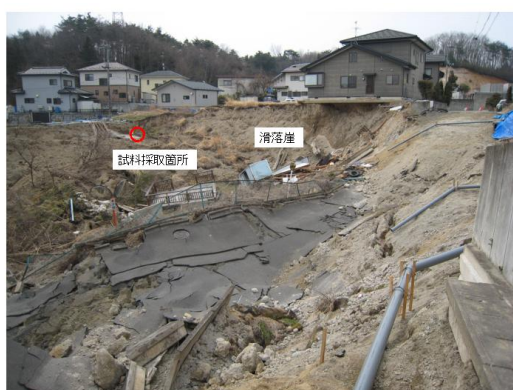
写真 4.3.2_8 木之崎の宅地の崩壊全景
