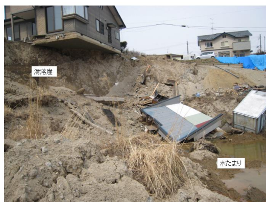
写真 4.3.2_10 滑落崖の下に現れた水たまり
