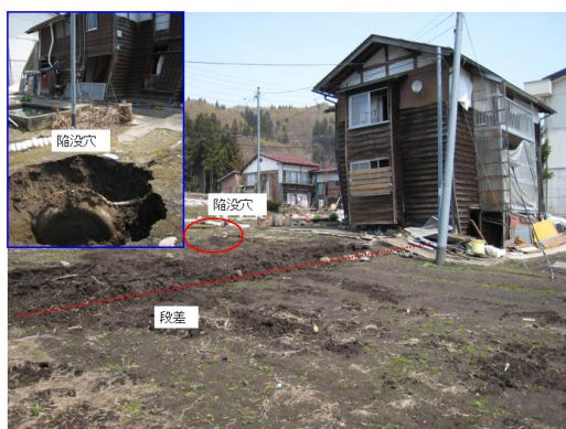
写真 4.3.3_8 栄小学校周辺の被害(図 4.3.3_6 の No.2 の箇所)
