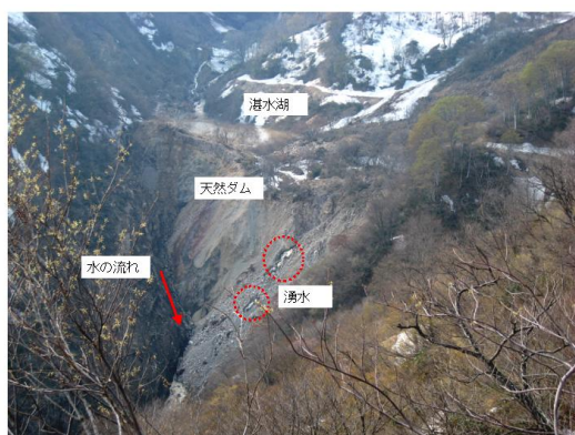
写真 4.3.3_18 北信の斜面崩壊 (湛水湖下部)
