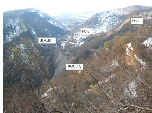
写真 4.3.3_16 北信の斜面崩壊（全景）
