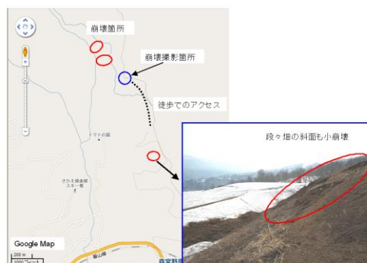
図 4.3.3_8 崩壊箇所へのアクセス
