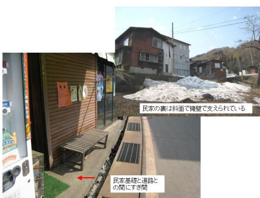
写真 4.3.3_13 森宮野原駅周辺の被害 (図 4.3.3_6 の No.5 の箇所)
