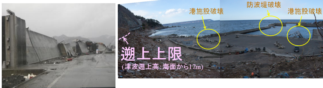
写真-2 防潮堤の破壊状況
