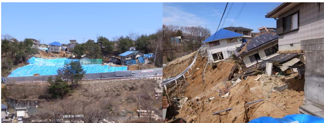
図 2.6 福島市あさひ台団地の被害（環境防災研究室）
