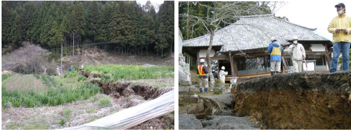
図 2.5 余震で発生した断層と断層変位による建物被害（環境防災研究室）
