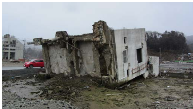
図 2.11 砂質地盤における杭構造形式建物の津波による転倒被害（環境防災研究室）
