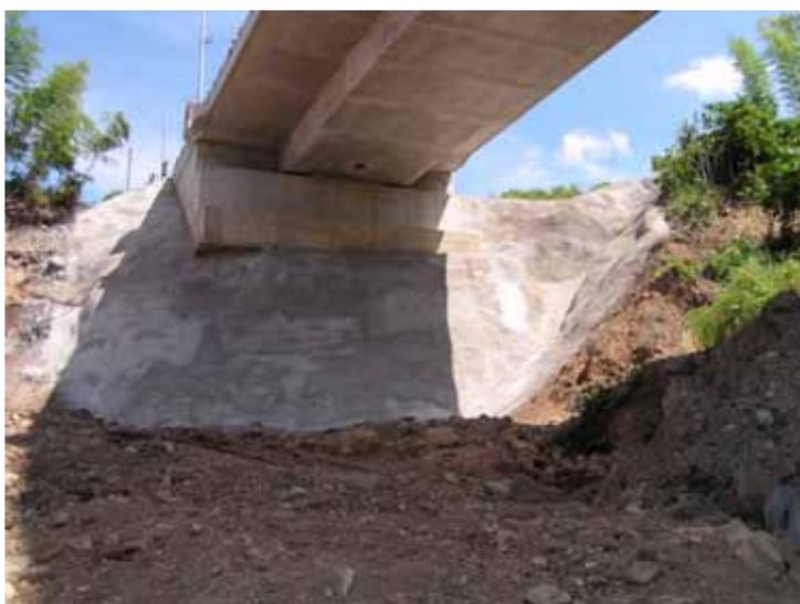
図 6-33 栃尾市平の地すべりにおける橋脚基礎地盤の流出
