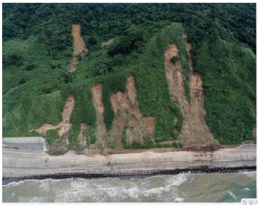
図 6-21 出雲崎町の国道 402 号線沿い斜面の表層崩壊（新潟県提供）
