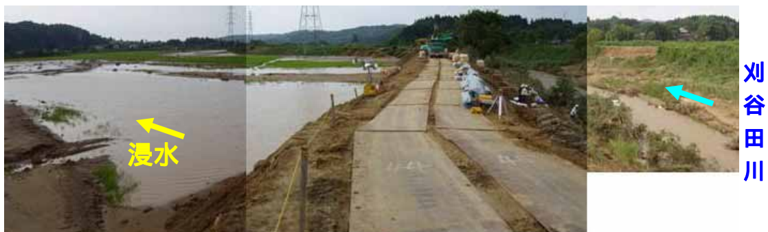
写真 4-3 破堤被災状況（稚児清水川合流箇所、見附市池之島町）
