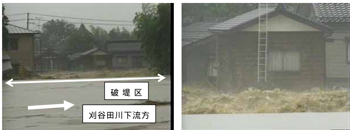
写真 4-8 中之島町左岸破堤点 図 1 の破堤点 に対応 左 破堤点全体図 右 破堤点近隣の家屋（上写真の中央部）
