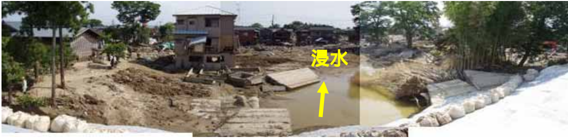
写真 4-9 被災状況（平成 16 年 7 月 22 日、破堤点上より写真 1 と同方向）
