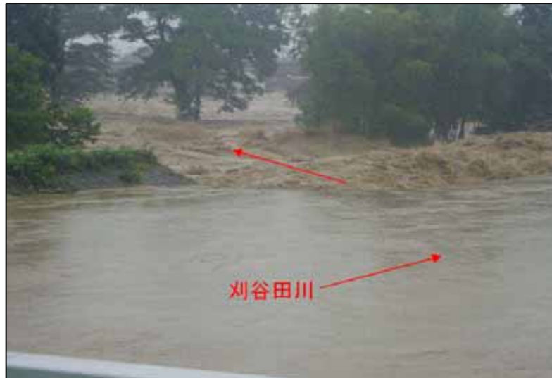
写真 3-2 中之島破堤点の破堤状況（国交省北陸地方整備局撮影 7.13）
