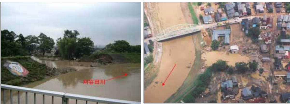
写真 3-3 中之島破堤点の破堤状況（左：国交省北陸地方整備局，右：新潟県 いずれも 7.14 撮影）
