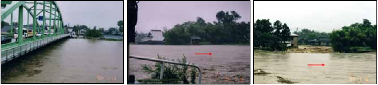
写真 3-1 中之島町破堤現場の推移（左：越水直前，中：破堤前越水，右：破堤後）
