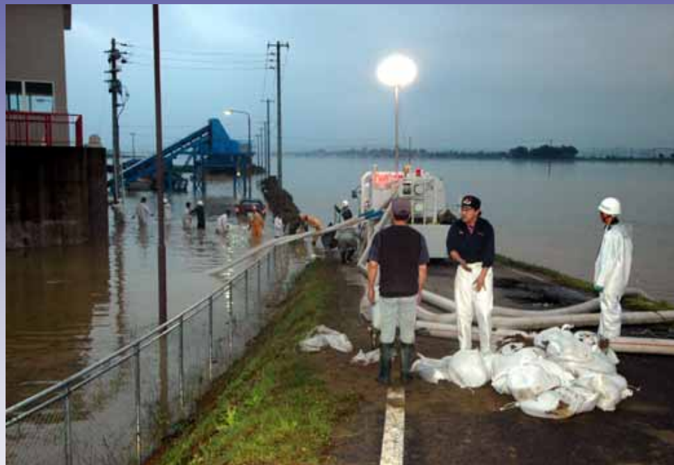
排水ポンプ車による排水作業を実施 (7月14日明け方)
