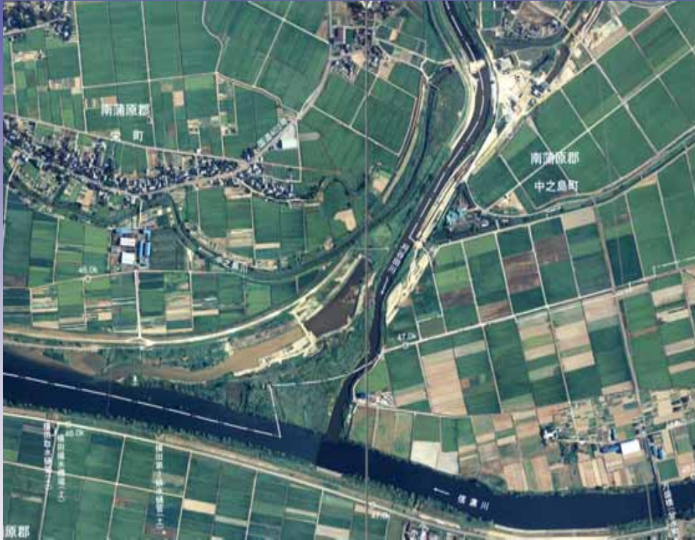
刈谷田川合流点(出水前) 平成11年8月撮影
