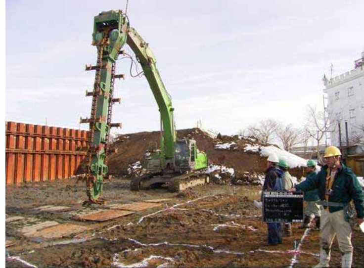
(写真2) 地盤改良トレンチャー攪拌工着手前 (左岸:見附市山吉町)
