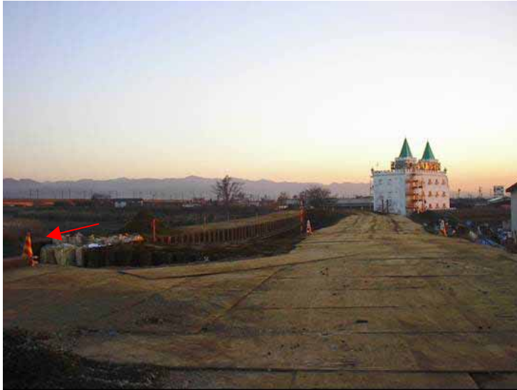
(写真1) 仮堤防完了時(左岸:見附市山吉町)
