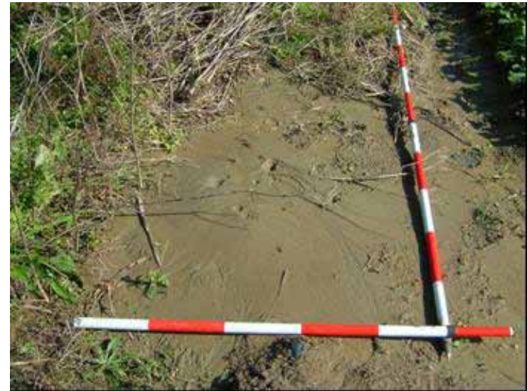
(写真4) 堤防法尻付近の噴砂跡
