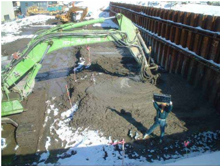
(写真3) 地盤改良トレンチャー攪拌工 (左岸川表側:見附市山吉町)
