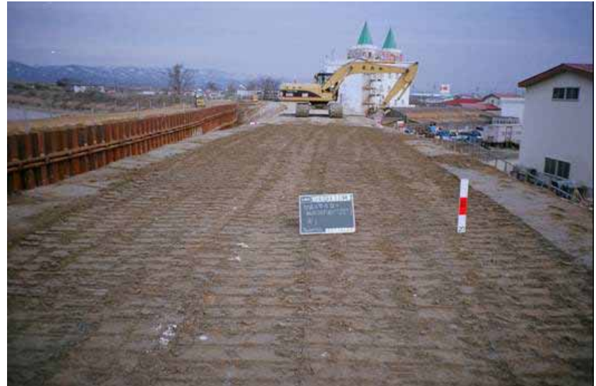
(写真4) 築堤時 築堤状況(左岸:見附市山吉町)
