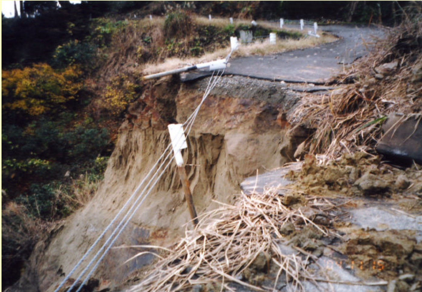
木沢トンネル脇の斜面崩壊 (川口町木沢)
